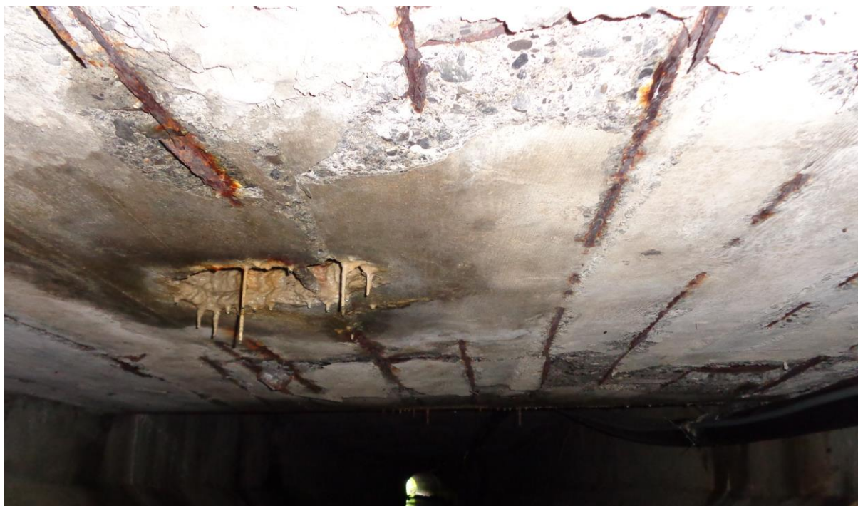
Legende: Betonschäden Decke Kanal (Foto: Amt für Mobilität)
