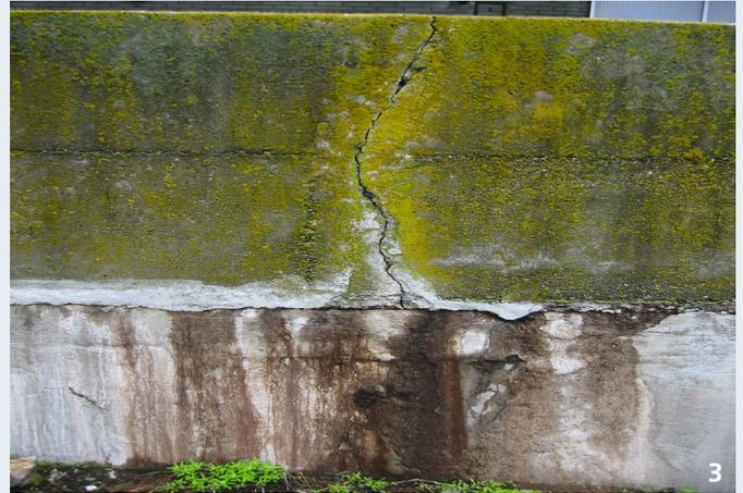
Es sind Spuren von Gülleaustritt am Güllebehälter, bei der Schieberung und/oder auf der umliegenden Fläche sichtbar. Die sichtbaren Leitungen weisen Risse oder undichte Stellen auf. Die Stahlbänder von Holz-Behältern sind rostig.
