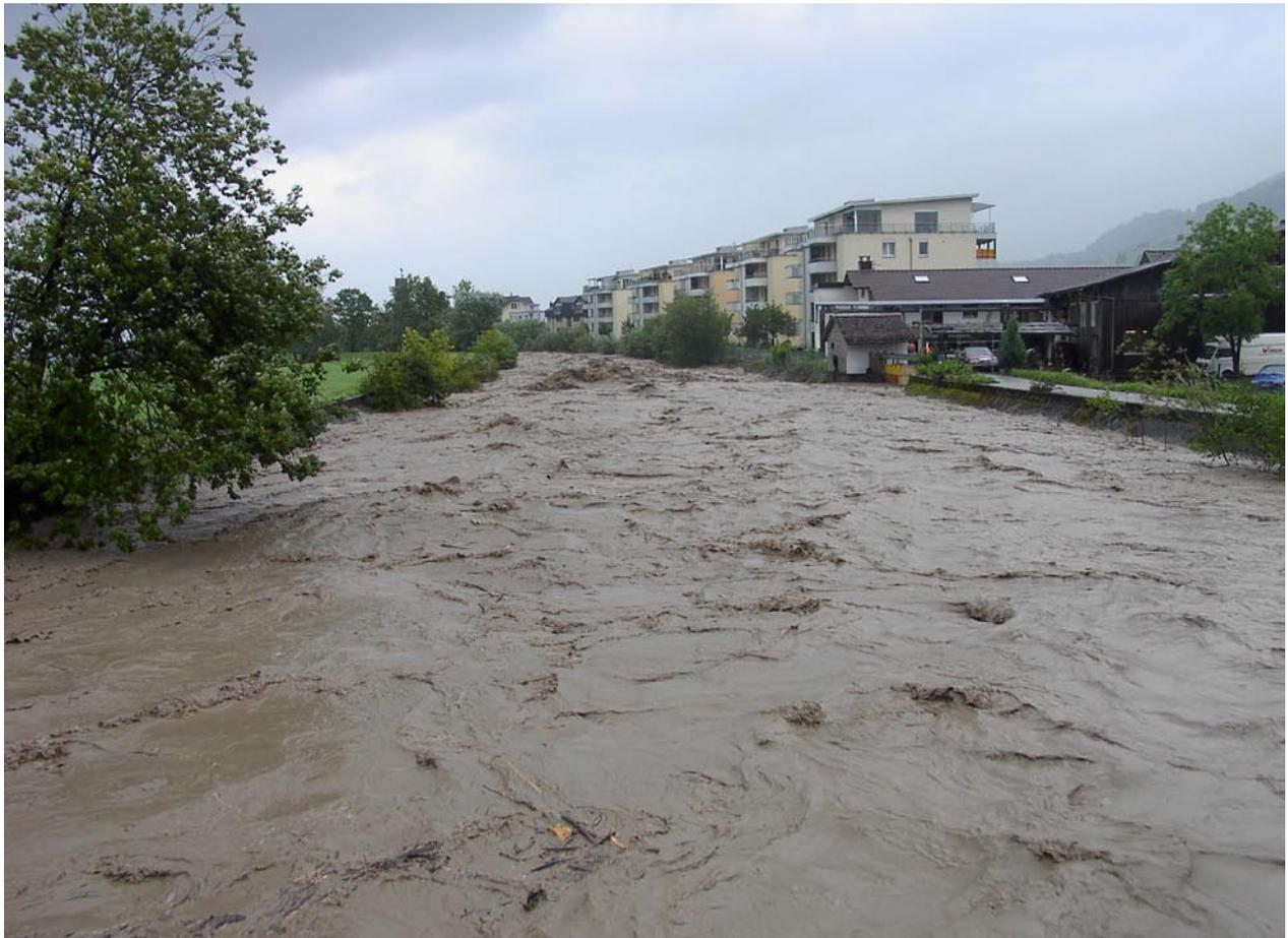
Die Abflussmenge von  $230 \text{ m}^3/\text{s}$  wurde selbsttätig auf die vorhandene Abflusskapazität von  $150 \text{ m}^3/\text{s}$  in Buochs entlastet. Ohne Entlastungen wäre ein Dambruch in Buochs nicht abzuwenden gewesen.
