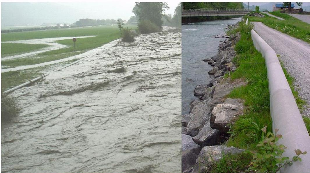
Vorentlastung Ennerberg: bei Hochwasser ( $205 \text{ m}^3/\text{s}$ ) fließt nur das „Zuviel“ an Wasser über die Streichwehrkante (Bild links); Vorentlastung bei Normalabfluss (Bild rechts)
