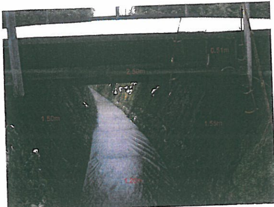
Bild: best. Zentralbahnbrücke
