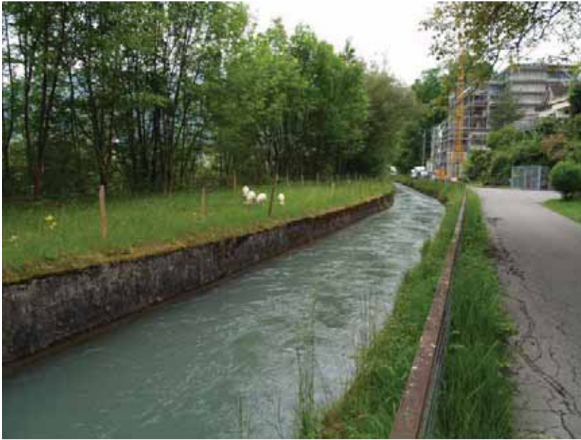
Unterwasserkanal, Blick abwärts
