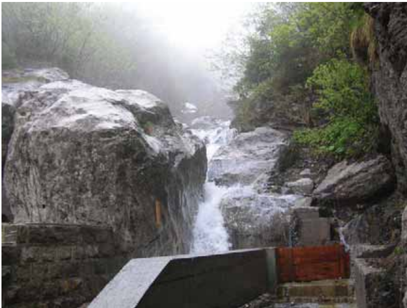
Fassung Wangbach mit Dammbalken rechts, Blick aufwärts
