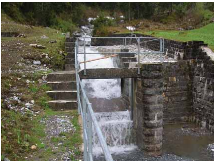
Tirolerwehr Fassung Trüebenbach oben Aufnahme vom 21.05.2008
