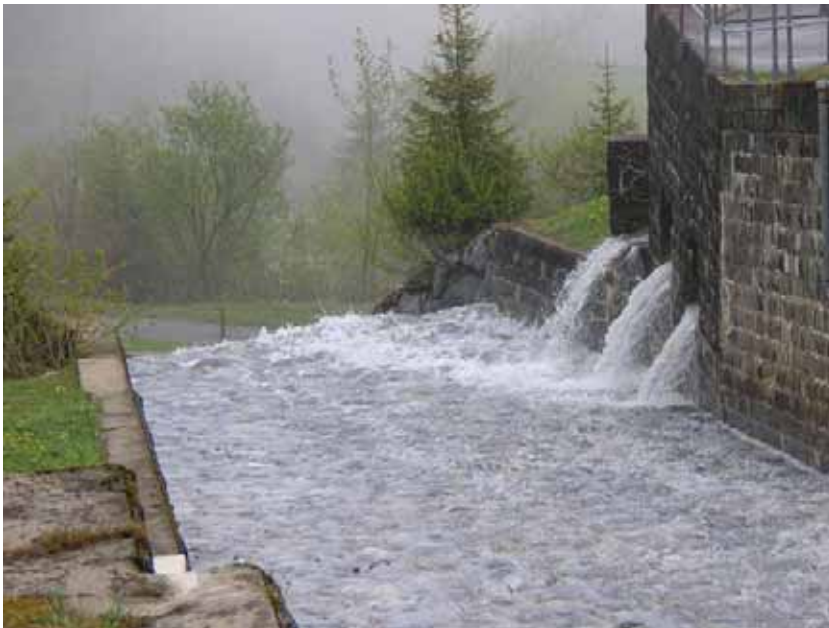
Überlaufvorrichtung des Ausgleichsbecken Untertrüebsee, Blick abwärts
