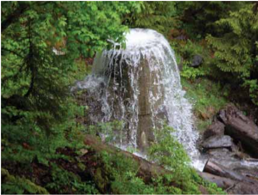
Überlauf der Wasserleitung (Düker), die zur Fassung Trübenbach unten Nr. 3.5 führt
