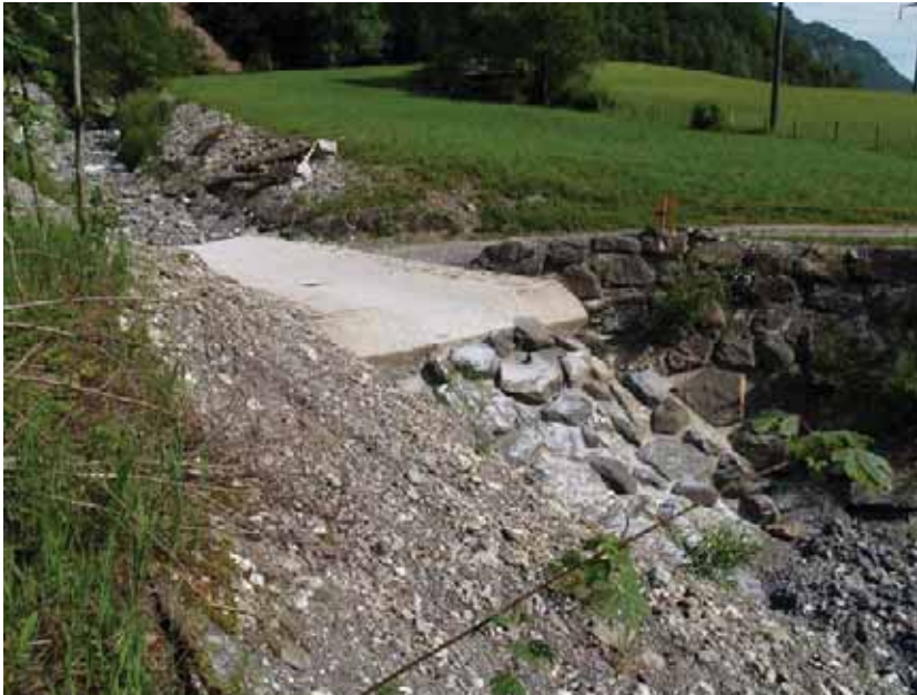
Künstlicher Absturz in der Restwasserstrecke ca. 50 m oberhalb der Mündung in die Engelberger Aa
