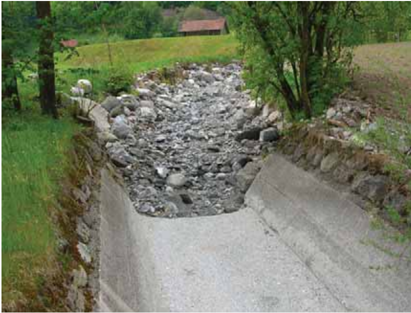
Restwasserstrecke direkt oberhalb verbauter Mündung in die Engelberger Aa, Blick aufwärts
