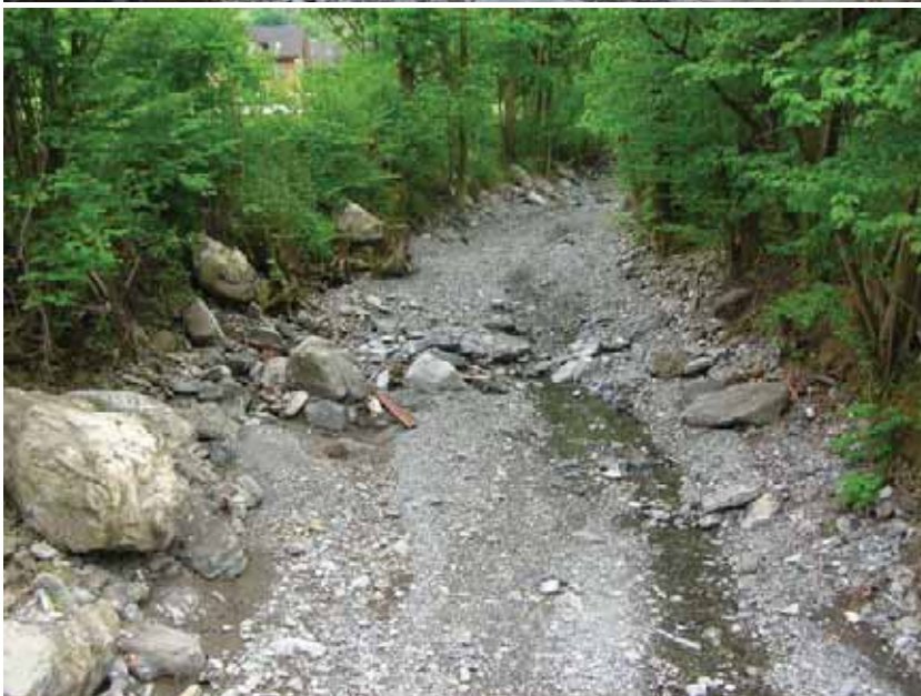
Restwasserstrecke oberhalb der Kantonsstrassenbrücke, Blick aufwärts
