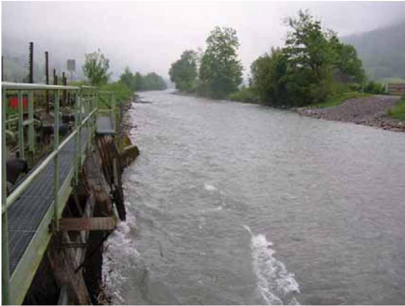
Engelberger Aa oberhalb Fassung Engelberger Aa, Hostetten, Links im Bild seitliche Wasserausleitung, Blick aufwärts
