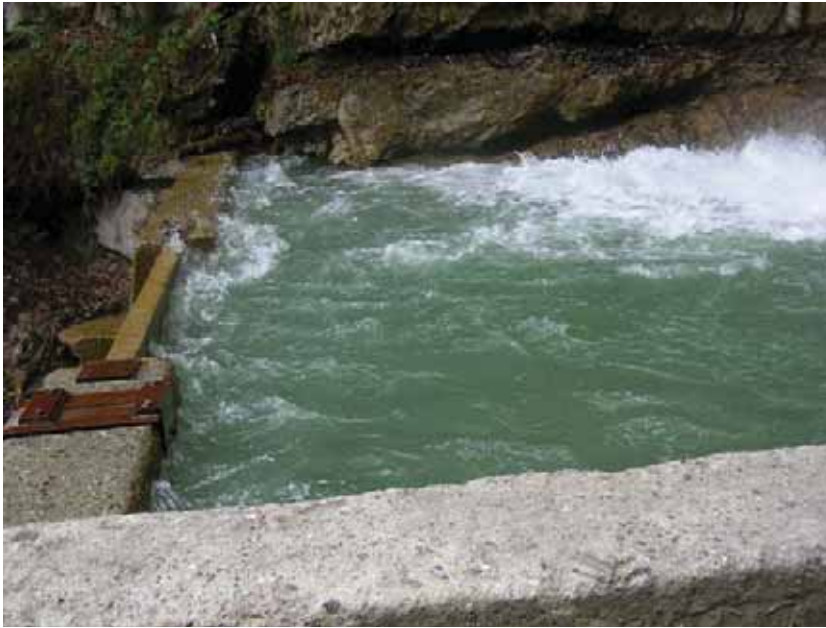
Wehr mit Dammbalken der Fassung Fallenbach
