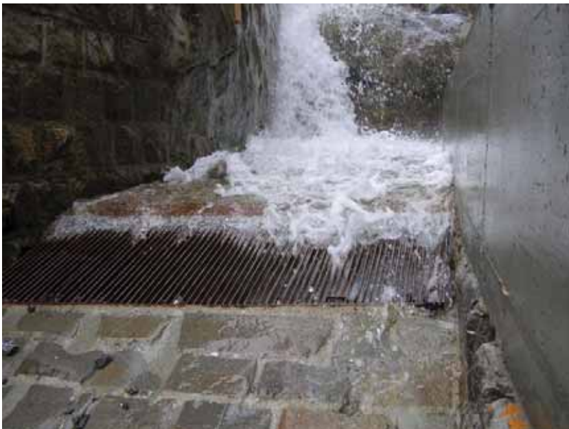
Detail Tirolerwehr der Fassung Wangbach, Blick abwärts
