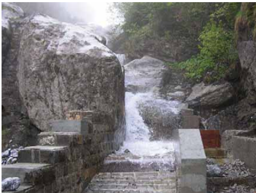
Tirolerwehr Fassung Wangbach Aufnahme vom 21.05.2008
