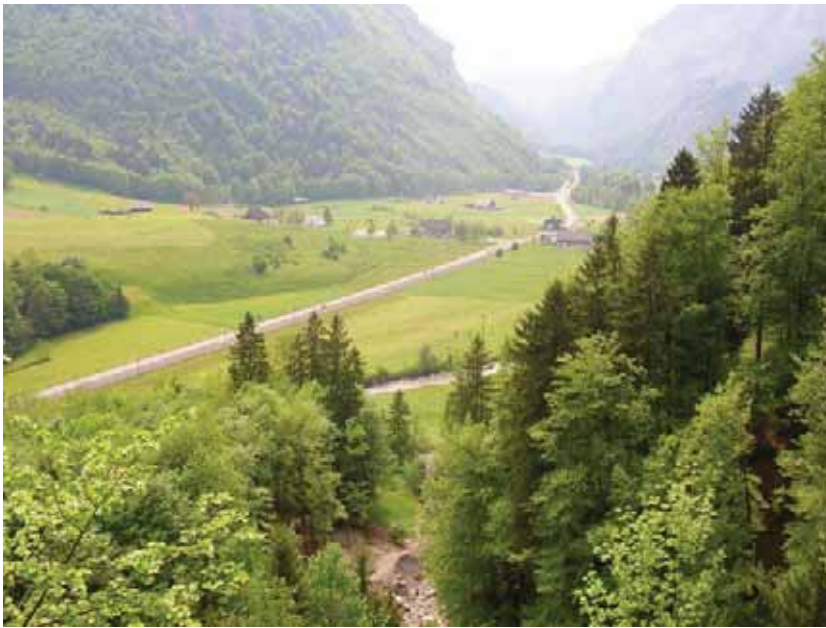
Restwasserstrecke im Vordergrund, Blick abwärts Richtung Grafenort.
