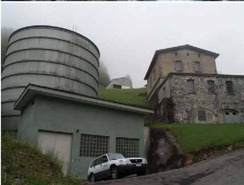
Wasserschloss des KW Obermatt
