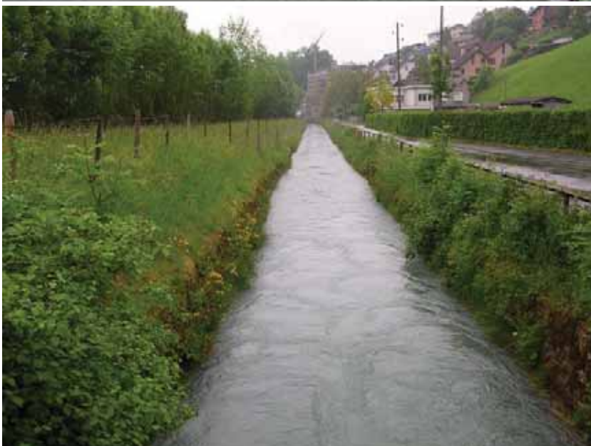
Oberwasserkanal, Blick abwärts
