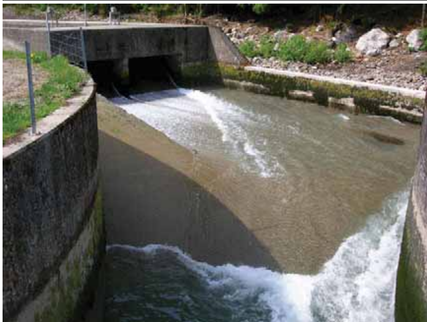
Ausleitbauwerk der Fassung Engelberger Aa, Obermatt
