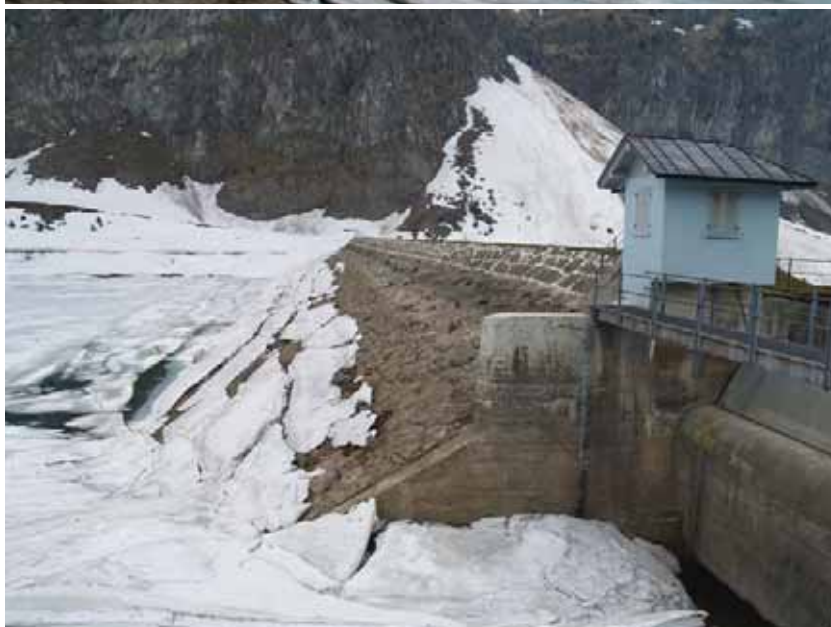
Staumauer Bannalpsee mit Wehrklappen im Vordergrund
