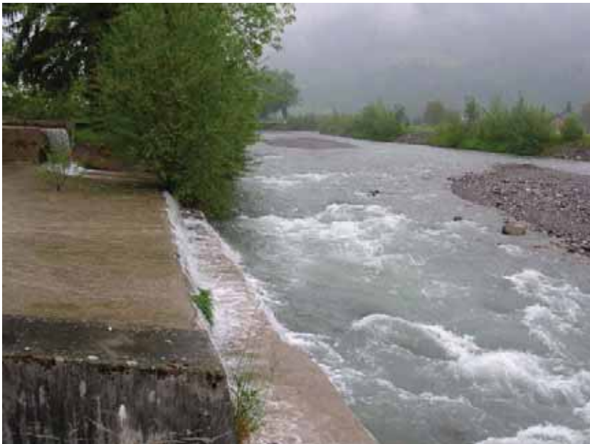
Überlauf in die Restwasser- strecke
