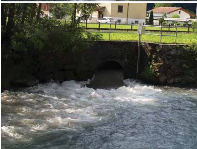
Wasserrückgabe des KW Wol- fenschiessen in die Engelber- ger Aa. Trübes Wasser.
