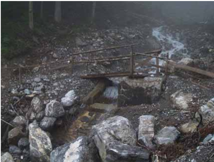
Fassung Eugenibach oben, Blick aufwärts
