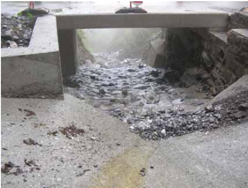
Wangbach direkt unterhalb der Fassung Wangbach, Blick abwärts
