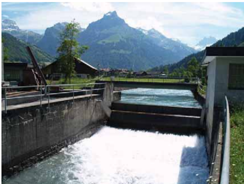
Schützenwehr der Fassung Engelberger Aa, Eugenisee. Situation mit Überlauf am Wehr, Blick aufwärts
