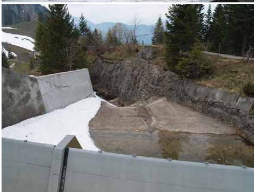
Restwasserstrecke direkt unterhalb der Fassung Bannalpsee, Blick abwärts
