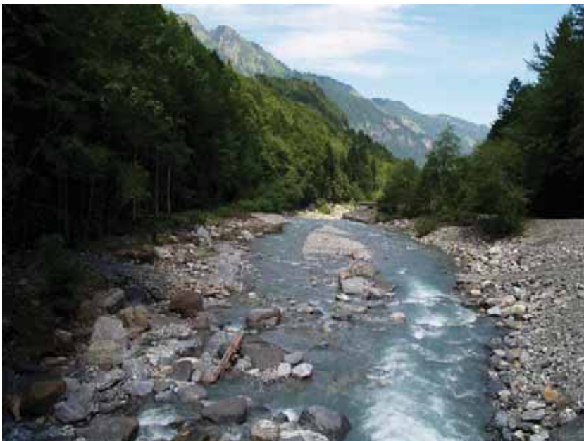
Restwasserstrecke der Engelberger Aa direkt oberhalb Obermatt, Blick abwärts. Situation mit Überlauf am Wehr
