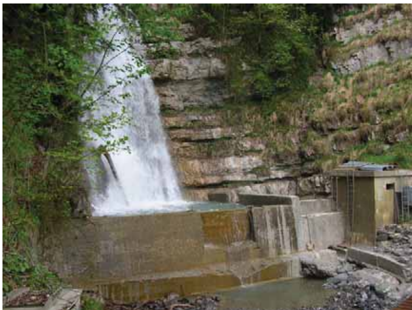
Wehr mit Dammbalken Fassung Fallenbach
