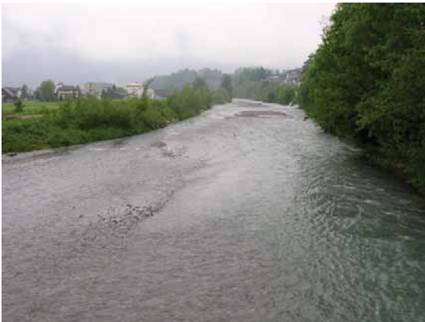
Restwasserstrecke mit Kiesbänken, Blick abwärts
