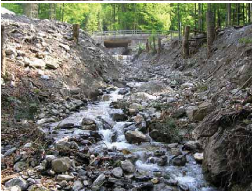
Restwasserstrecke kurz oberhalb der Fassung Eugenibach unten Nr. 5.8. Im Hintergrund ist der künstliche Absturz bei der Kantonsstrassenunterquerung zu erkennen, Blick aufwärts
