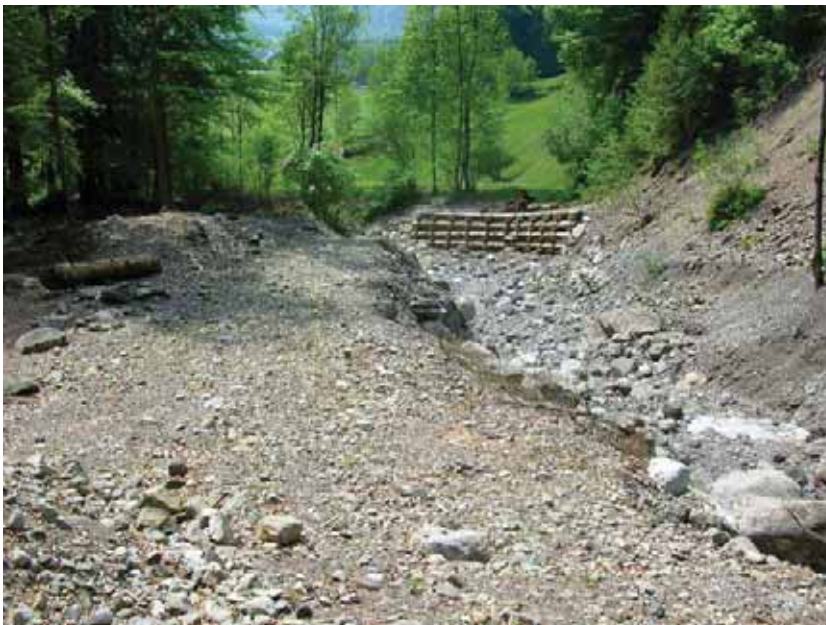
Restwasserstrecke unterhalb der Talflanke, Blick abwärts
