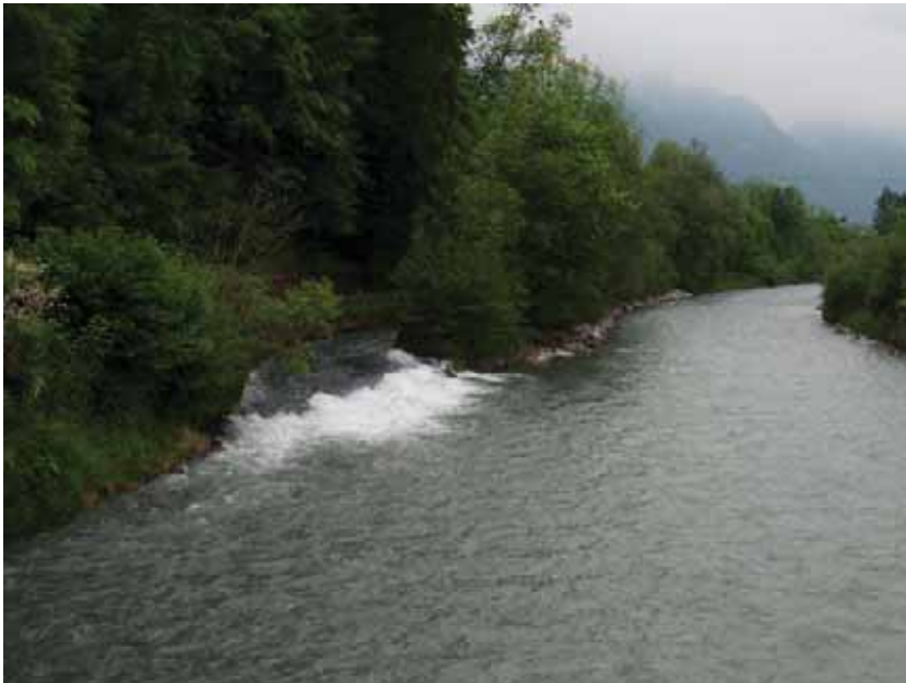
Wasserrückgabe in die Engelberger Aa, Blick aufwärts
