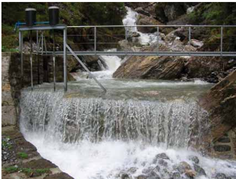
Schützenwehr der Fassung Trüebenbach unten. Situation mit Wehrüberfall
