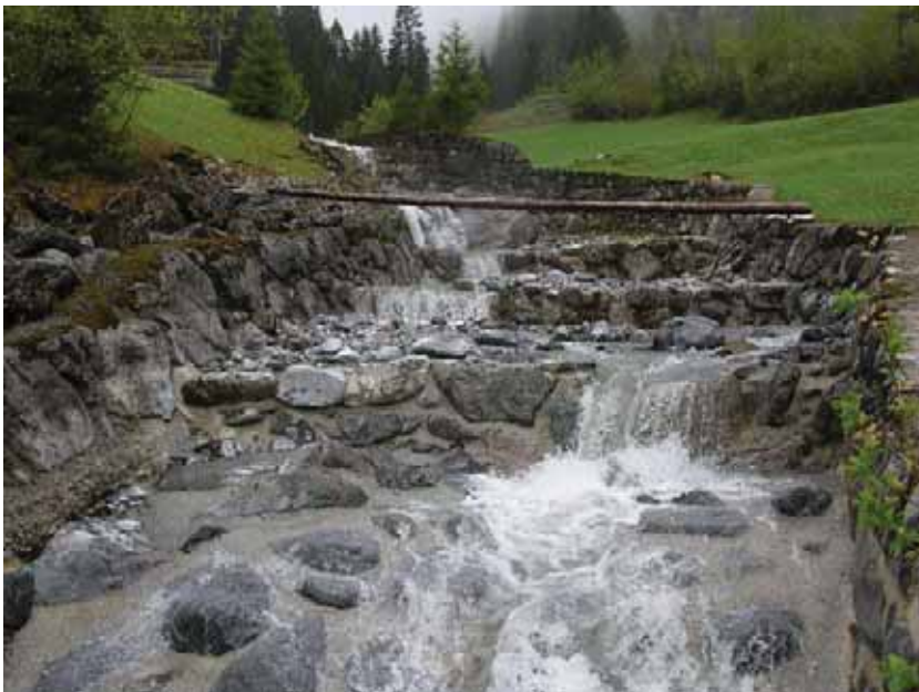
Verbautes Gerinne direkt unterhalb der Fassung Trüebenbach oben, Blick aufwärts
