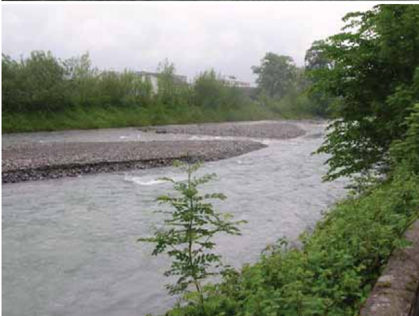
Restwasserstrecke mit Kiesbänken, Blick abwärts
