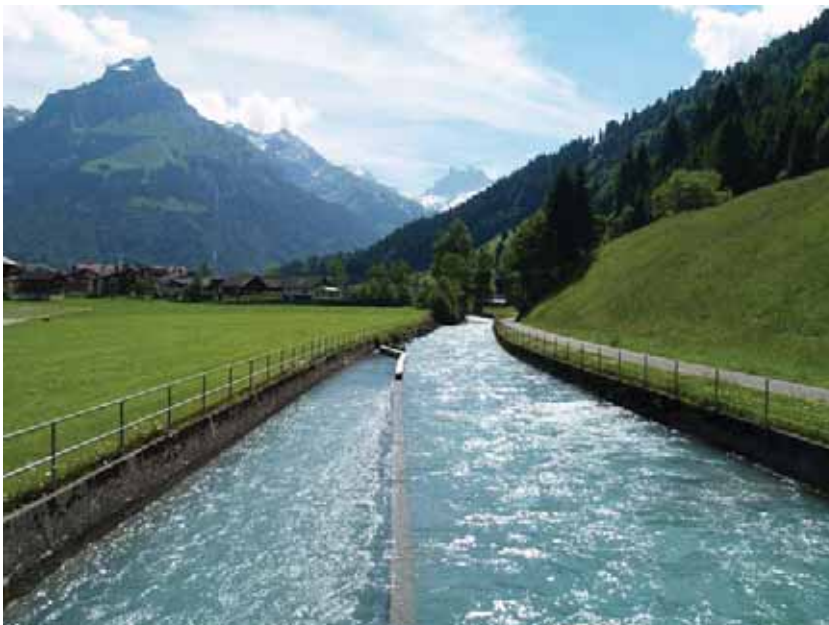
Sandfang der Fassung Engel- berger Aa, Eugenisee, Blick aufwärts
