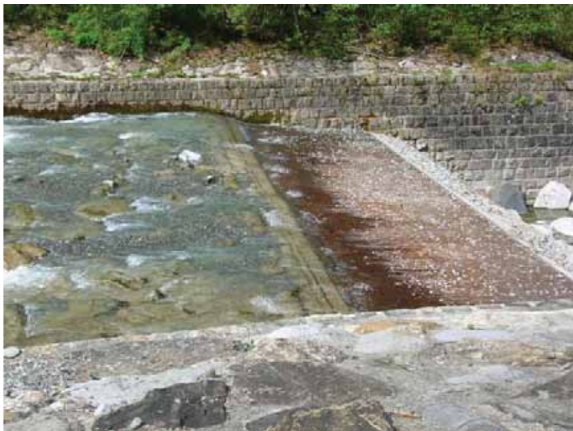
Tiroler Wehr Fassung Obermatt Aufnahme vom 15.05.2008
