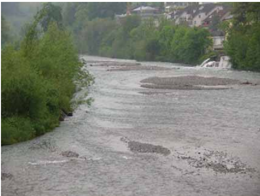
Restwasserstrecke mit Kiesbänken, rechts im Bild ist der Überlauf des Oberwasserkanals sichtbar, Blick abwärts
