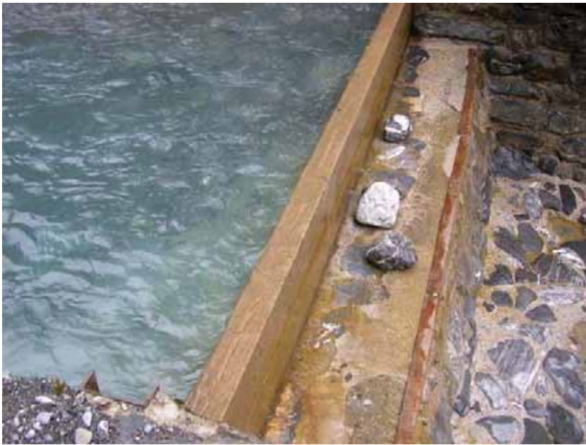
Damm balken der Fassung Arnibach unten
