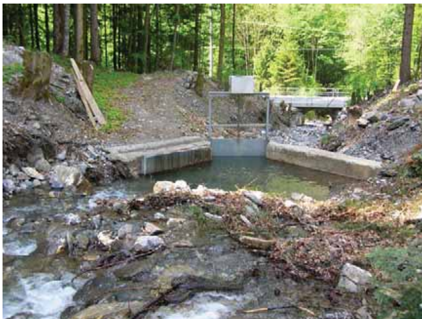
Wehr mit Schütze, Fassung Eugenibach unten Aufnahme vom 15.05.2008
