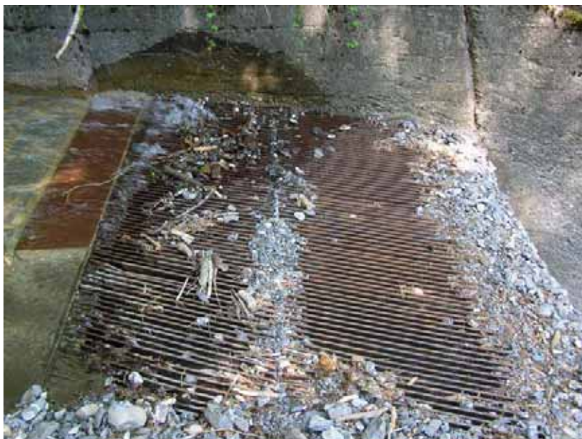
Tirolerwehr Fassung Gerbibach Aufnahme vom 15.05.2008
