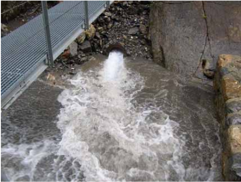
Offener Einlauf der Wasserleitung aus der Fassung Arni-bach unten Nr. 3.4
