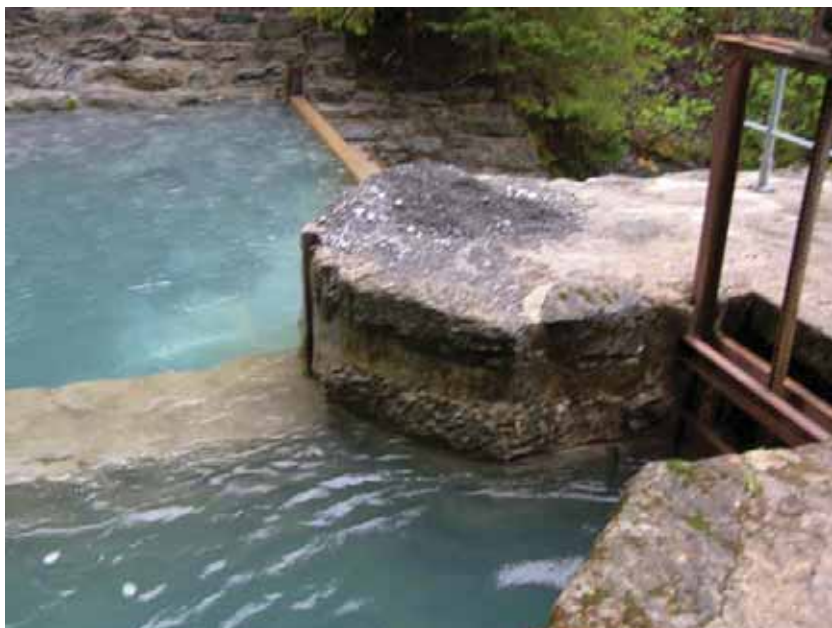
Schützenwehr mit Dammbalken der Fassung Arnibach unten
