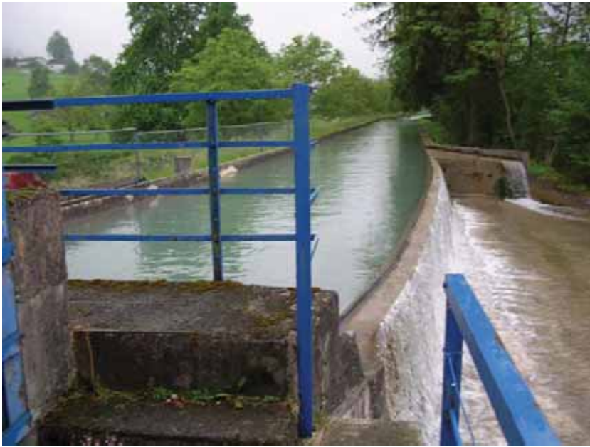
Überlauf oberhalb Zentrale, Blick aufwärts
