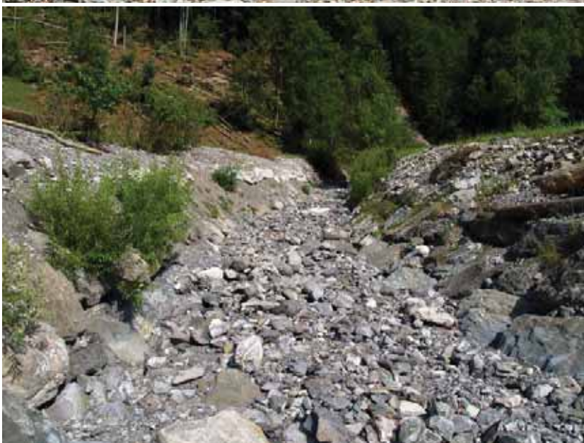
Restwasserstrecke oberhalb Absturz, Blick aufwärts
