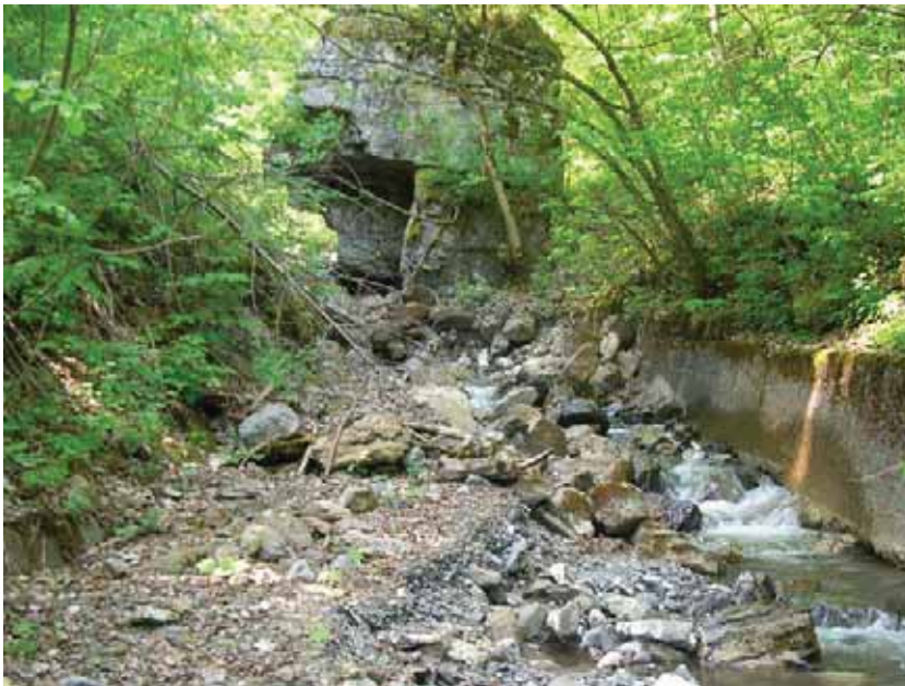
Gerbibach direkt oberhalb der Fassung, Blick aufwärts.
