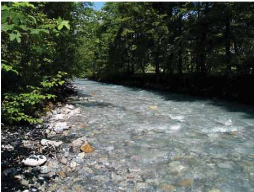
Restwasserstrecke unterhalb Fassung Engelberger Aa, Eugenisee. Situation mit Überlauf am Wehr, Blick abwärts.
