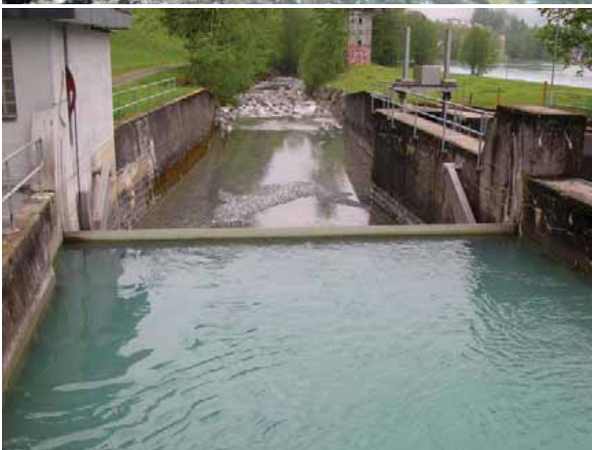
Fassung Engelberger Aa, Eugenisee, Schützenwehr und Tosbecken, Blick abwärts.
