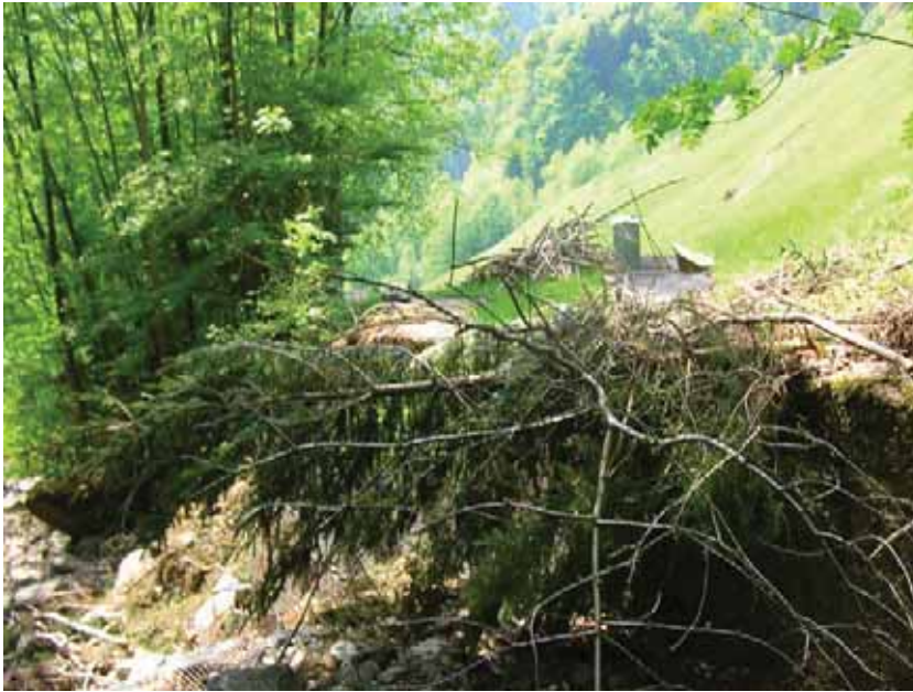
Tirolerwehr Grüeblenbach links im Vordergrund mit Blick Richtung Sandfang
