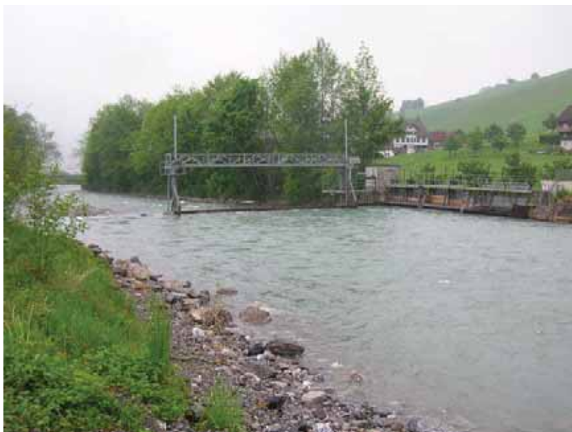
Schützenwehr Fassung Engelberger Aa, Hostetten
