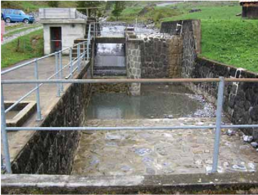
Tosbecken der Fassung Arnibach oben, Blick aufwärts
