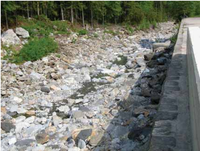
Restwasserstrecke direkt unterhalb der Fassung Engelberger Aa, Obermatt, Blick abwärts.
