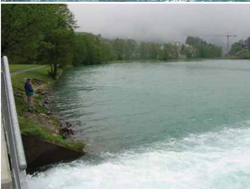
Ausgleichsbecken Eugenisee mit Einlauf des gefassten Wassers aus der Fassung En- gelberger Aa, Eugenisee im Vordergrund
