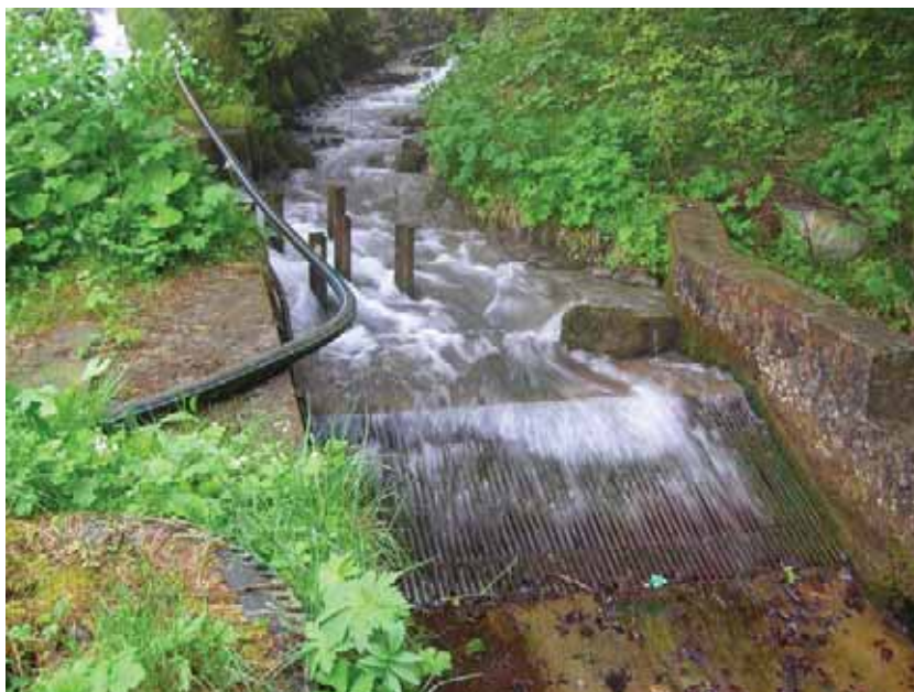
Tirolerwehr der Fassung Schuemettlenbach
