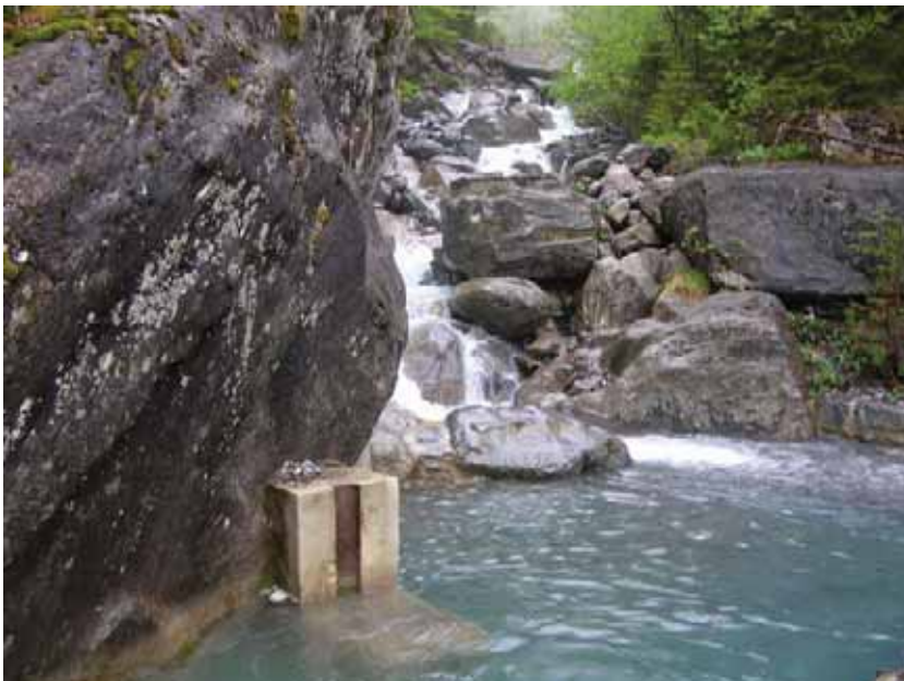
Arnibach direkt oberhalb der Fassung Arnibach unten (Sandfang im Vordergrund)
