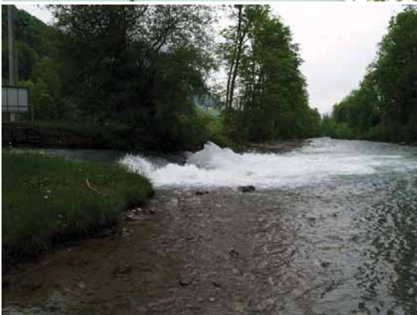
Wasserrückgabe des KW Dallenwil in die Engelberger Aa
