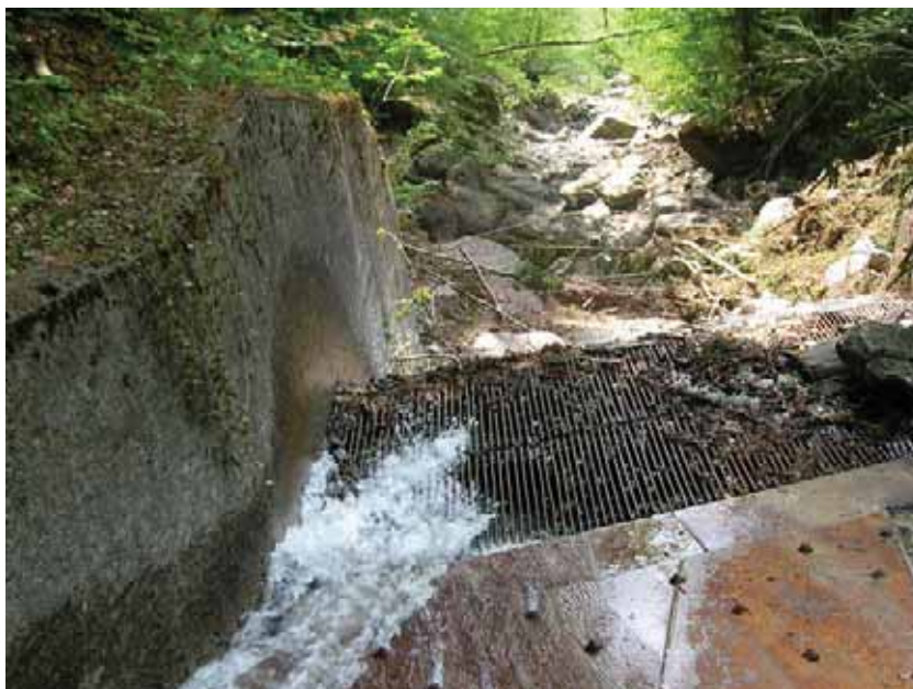
Tirolerwehr Fassung Grüeblenbach Aufnahme vom 15.05.2008
