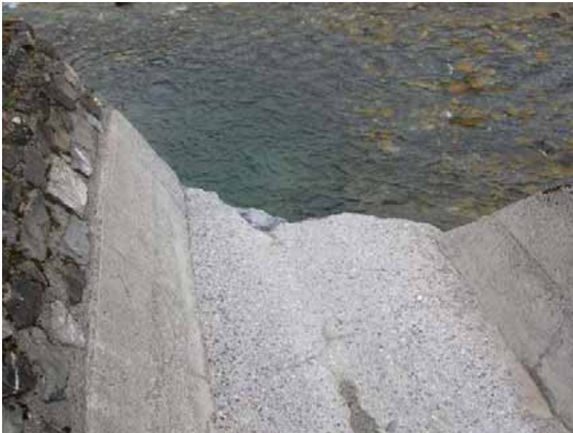
Verbauter Mündungsbereich mit Absturz
