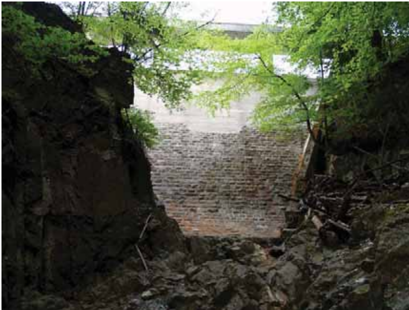
Staumauer Chäppelistutz. Beginn der Restwasserstrecke im Vordergrund, Blick aufwärts
