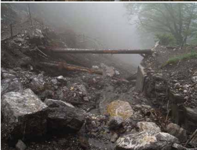
Restwasserstrecke direkt un- terhalb der Fassung Eugeni- bach oben, Blick aufwärts
