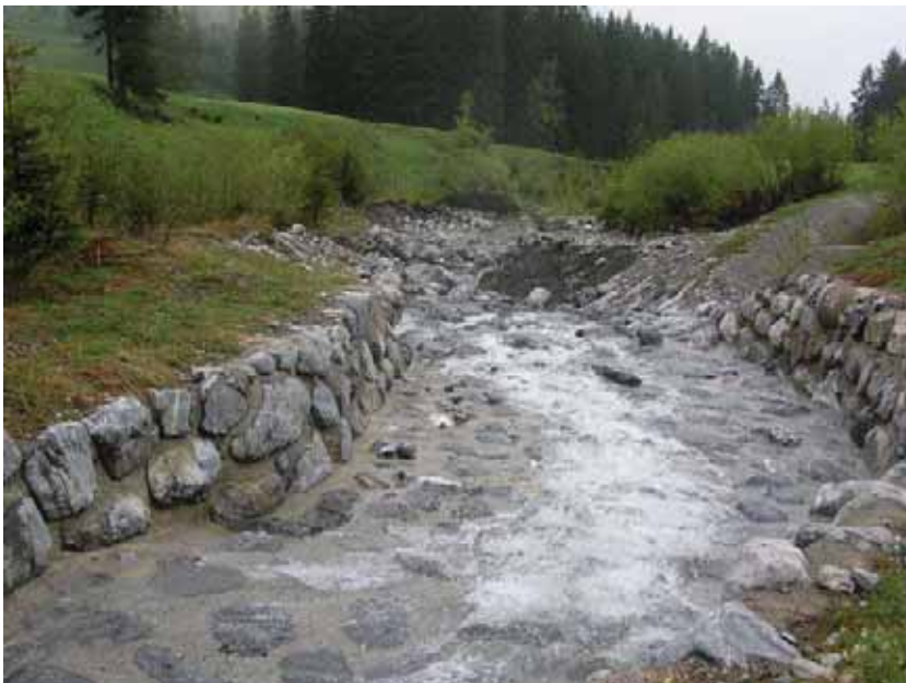
Verbautes Gerinne des Trüebenbachs unterhalb der Fassung Trüebenbach oben, Blick abwärts
