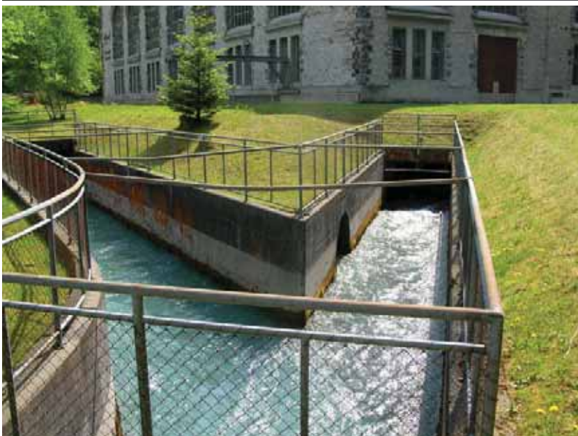
Wasserrückgabe des KW Obermatt ins Ausgleichbecken Obermatt
