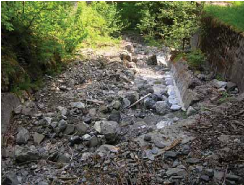
Restwasserstrecke direkt unterhalb der Fassung, Blick abwärts
