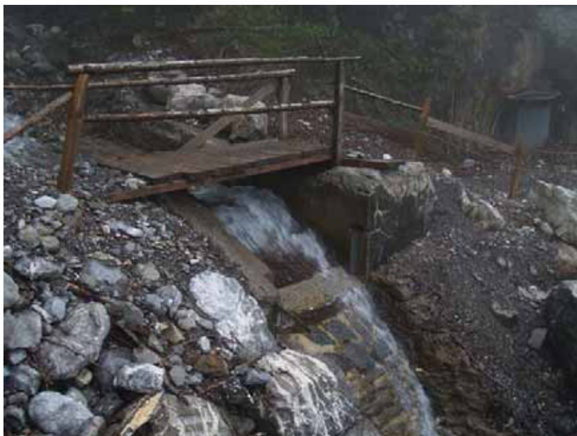
Tirolerwehr der Fassung Eugenibach oben
