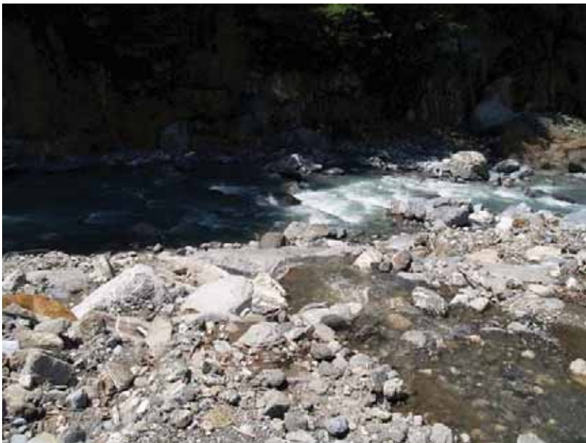
Mündung Eugenibach in die Engelberger Aa (Wehrüberlauf an den Fassungen Eugenibach unten und Engelberger Aa, Obermatt), Blick abwärts
