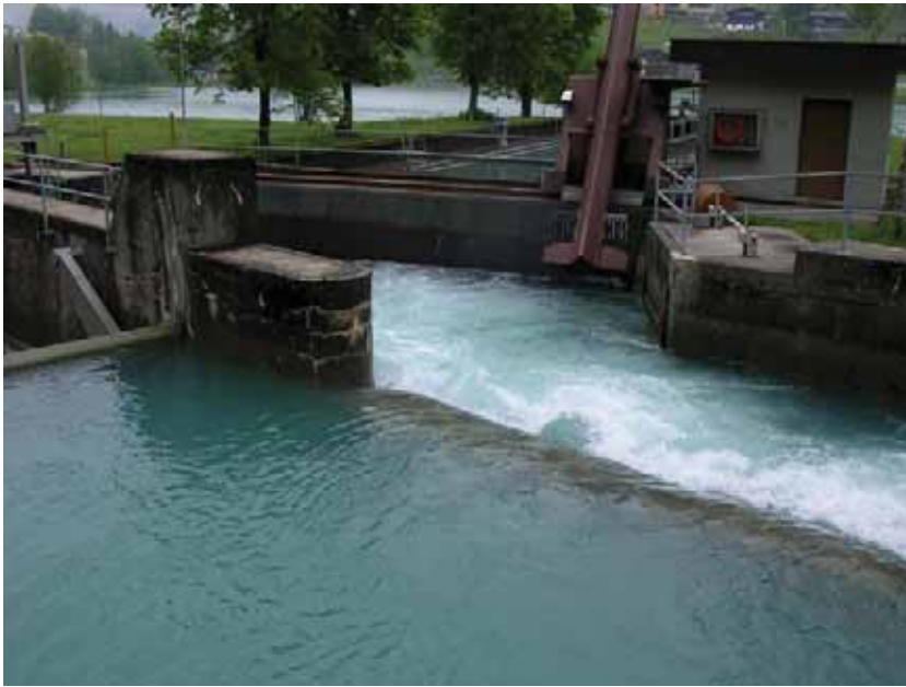
Ausleitbauwerk der Fassung Engelberger Aa, Eugenisee
