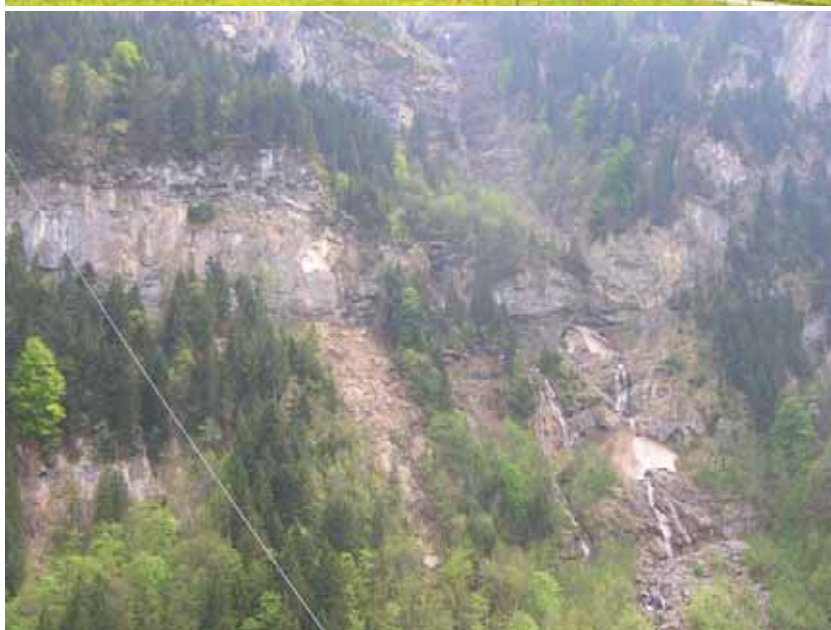
Detail der Restwasserstrecke im steilen, felsigen Abschnitt, Blick aufwärts
