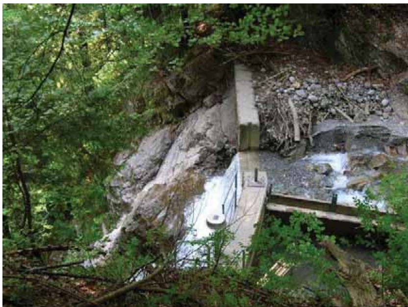
Wehr mit Dammbalken Fassung Luterseebach
