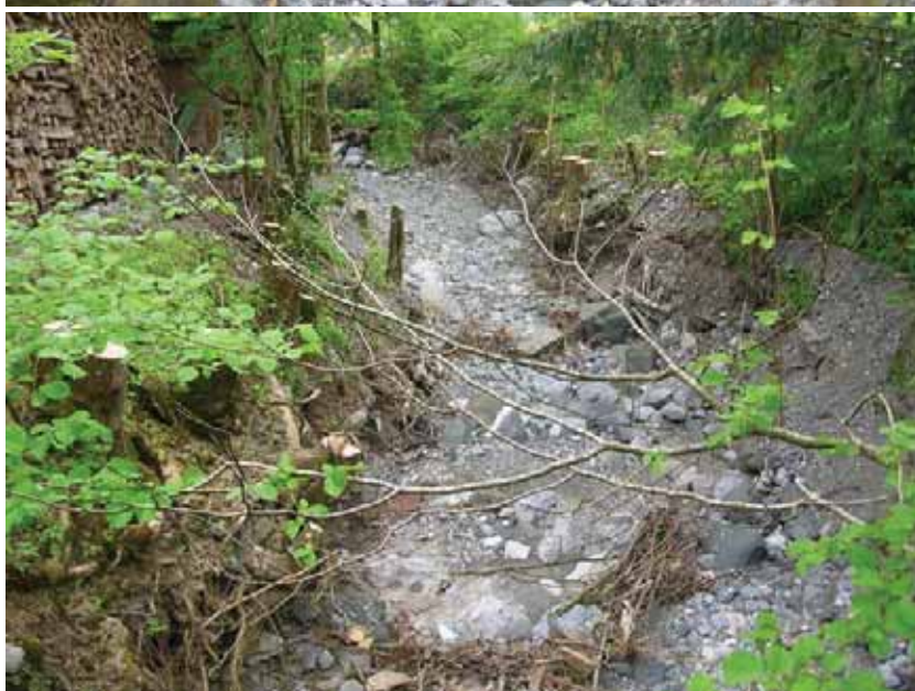
Restwasserstrecke im unteren flacheren Abschnitt, Blick aufwärts
