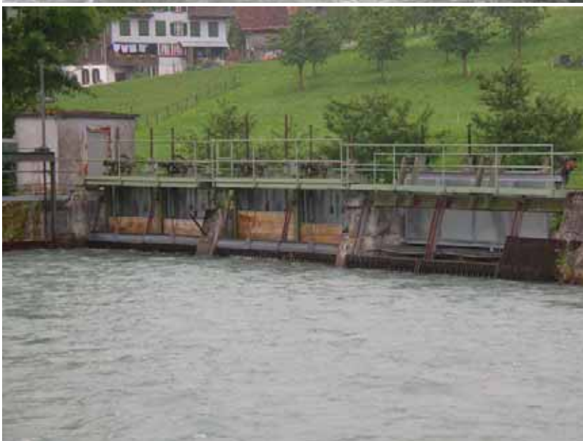
Fassung Engelberger Aa, Hostetten, seitliche Wasserausleitung mit Rechen
