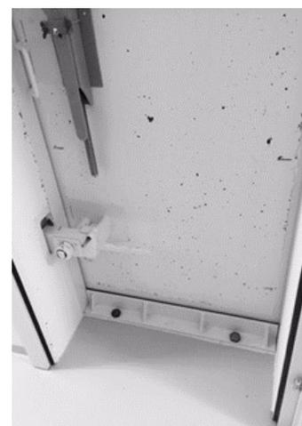
Panzertüre (PT1) mit demontierbarer Schwelle
