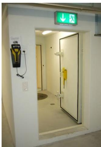
Panzertüre (PT1) mit betonierter Schwelle
