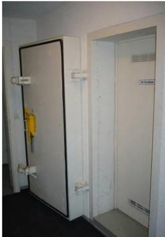
Panzertüre (PT1) mit betonierter Schwelle
