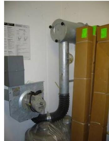
Schutzraumausrüstung beim Ventilationsaggregat
