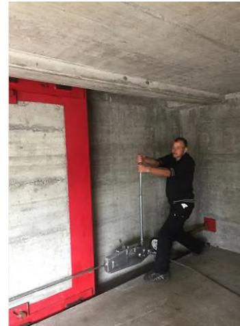
Panzerschiebewand (PSW) mit Seilzugapparat
