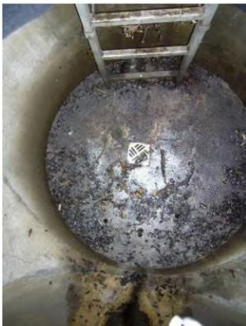
Sickerung mit Bodenablauf
