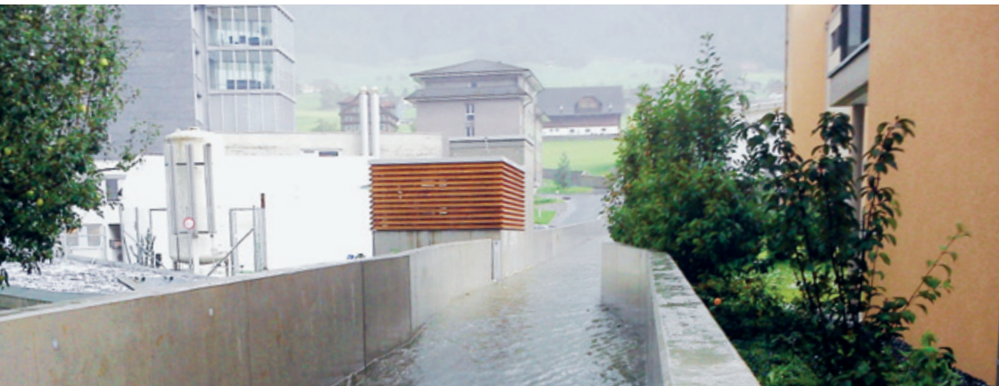
Die Schutzverbauung im Gebiet Kantonsspital / Wirzboden am 11.09.2011
