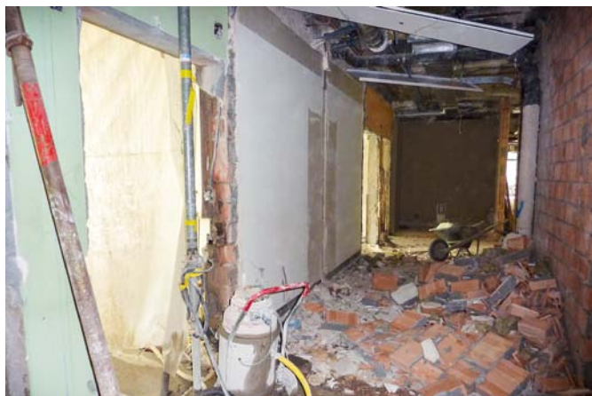
BAU Pflegestation während der Umbauphase
