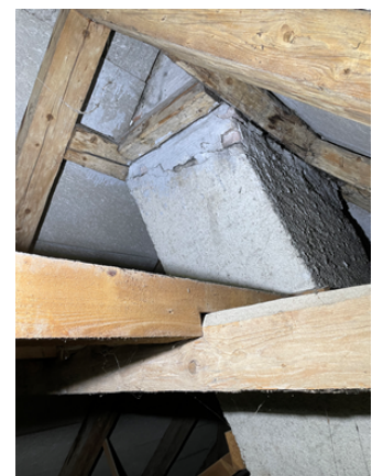
Dachstock: In guten Zustand / wärmetechnische Mängel im Dachgeschoss / GEA Unterdach mit Altlasten
