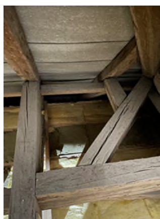
Dachstock: In guten Zustand / wärmetechnische Mängel im Dachgeschoss / GEA Unterdach mit Altlasten
