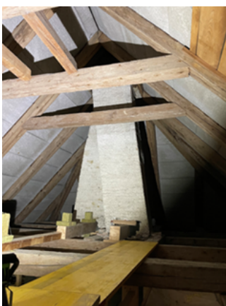
Dachstock: In guten Zustand / wärmetechnische Mängel im Dachgeschoss / GEA Unterdach mit Altlasten
