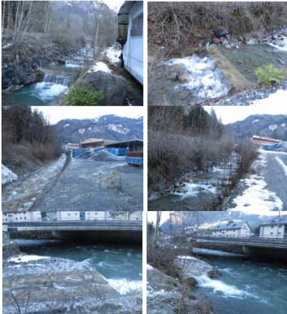
(Im oberen Teil sind Querriegel und teilweise grosse, tiefere Kolken und sandig-kiesigem Bett vorhanden; der untere Teil besteht aus einer vollständig hartverbauten, geschlossenen Schale mit kleineren Schwellen. (Fotos: A. Stäubli 2015)
