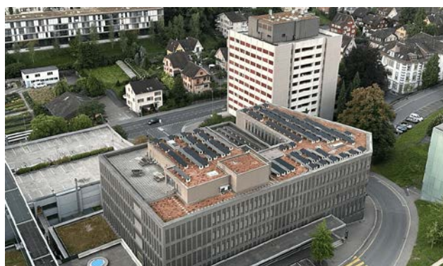
Vom Spitalzentrum aus ist die neue PV-Anlage auf der Augenklinik gut sichtbar.
