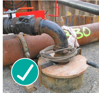
Abgedeckter Filterbrunnen
