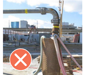
Keine Einleitung von Baugrubenabwasser ins Grundwasser!
