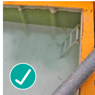
Becken mit guter Absetzwirkung
