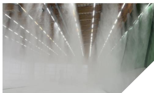
Löschanlage ca. 20 Sekunden nach Auslösung, Quelle: NSV
