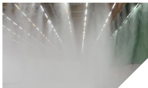
Löschanlage ca. 30 Sekunden nach Auslösung, Quelle: NSV
