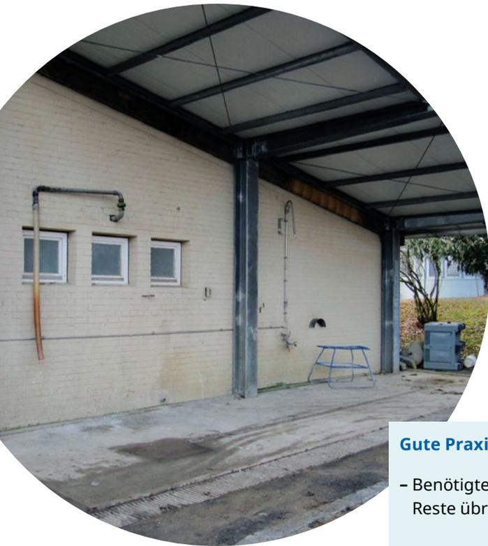
Stationärer Befüllplatz mit Gefälle, Überdachung und Ableitung in einen Sammelbehälter
