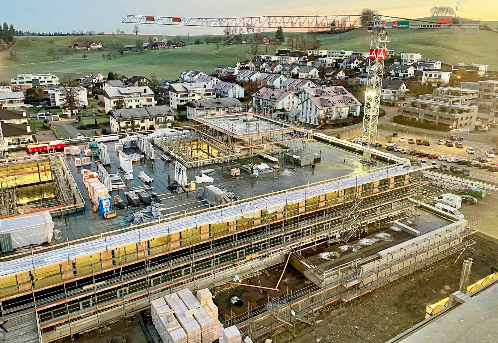
Baustelle Spitalneubau LUKS Wolhusen.
