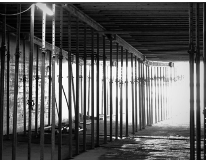
Impressionen von der Baustelle
