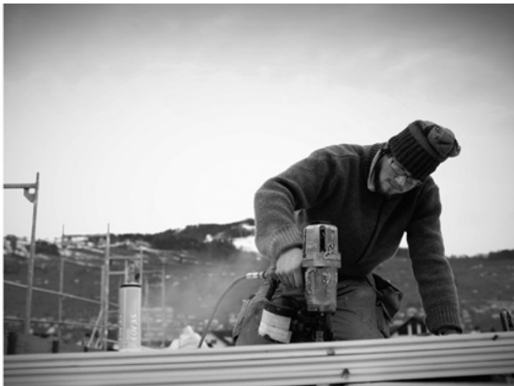
Impressionen von der Baustelle
