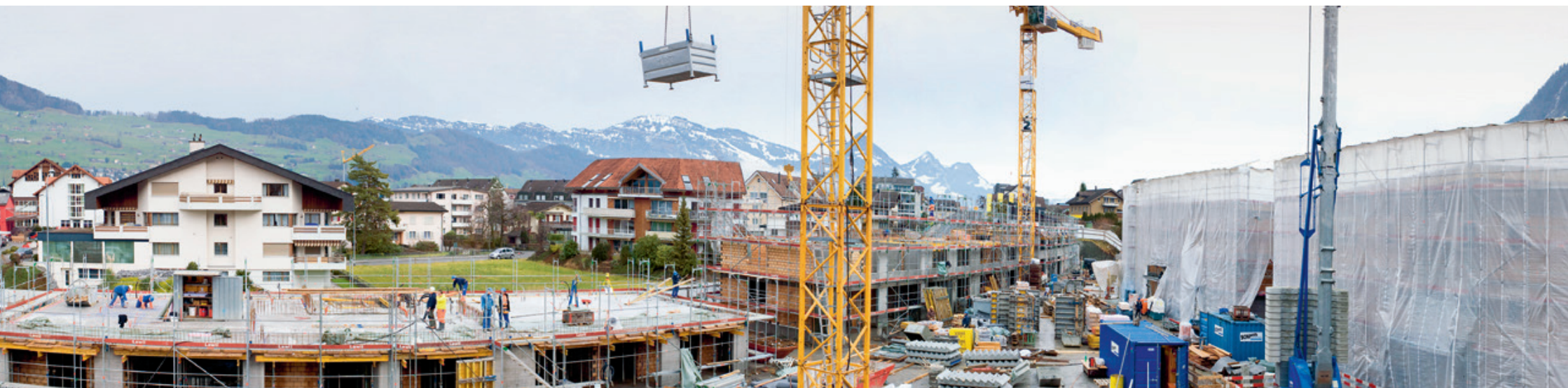
Blick auf die Baustelle Mühlematt, Buochs
