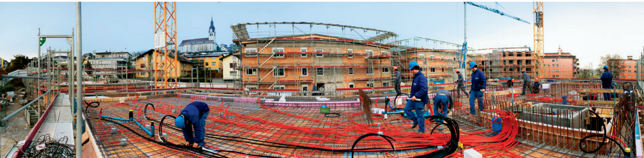
Blick auf die Baustelle Mühlematt, Buochs
