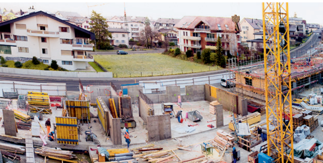
Blick auf die Baustelle Mühlematt, Buochs
