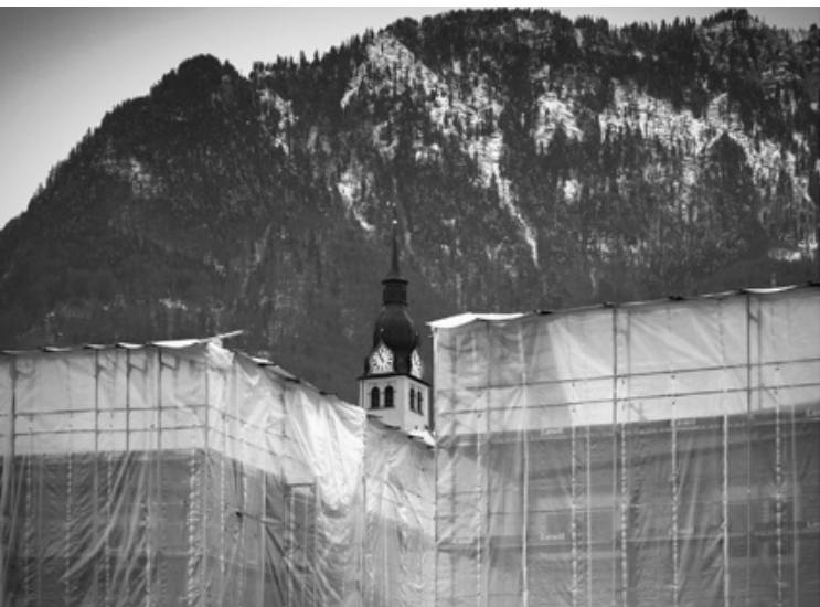
Impressionen von der Baustelle
