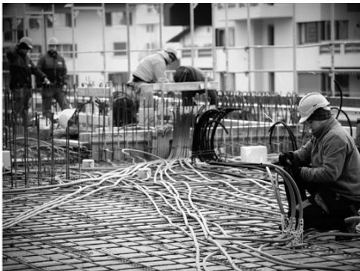
Impressionen von der Baustelle
