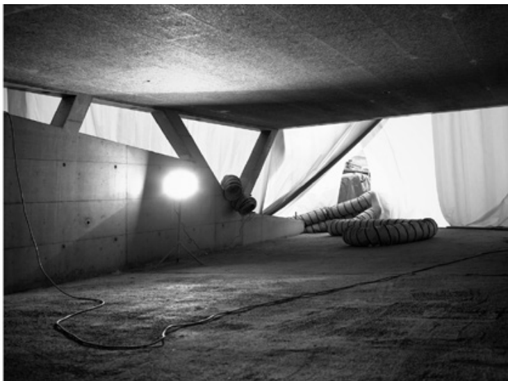
Impressionen von der Baustelle
