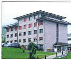
Das Kantonsspital Nidwalden in Stans.
