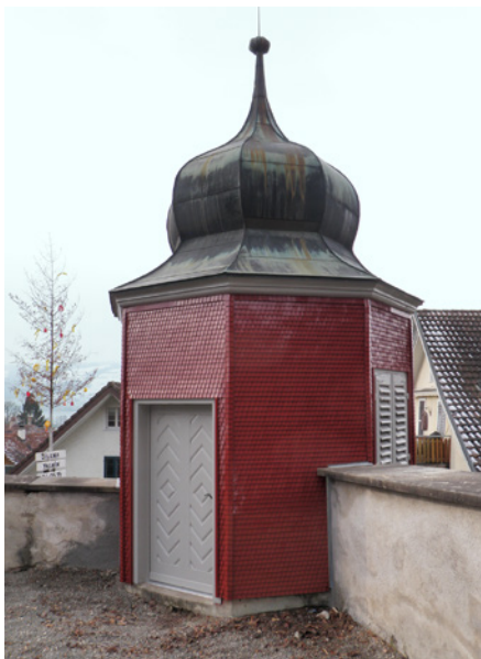
Sanierung eines Erkers: Ein Beispiel für zahlreiche im Berichtsjahr getätigte Investitionen.
