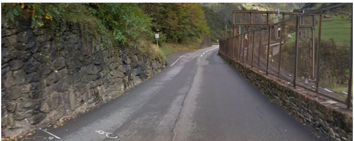
Abb. 7: Beispiel unterbrochene Mittellinie bei Gotthardstrasse
