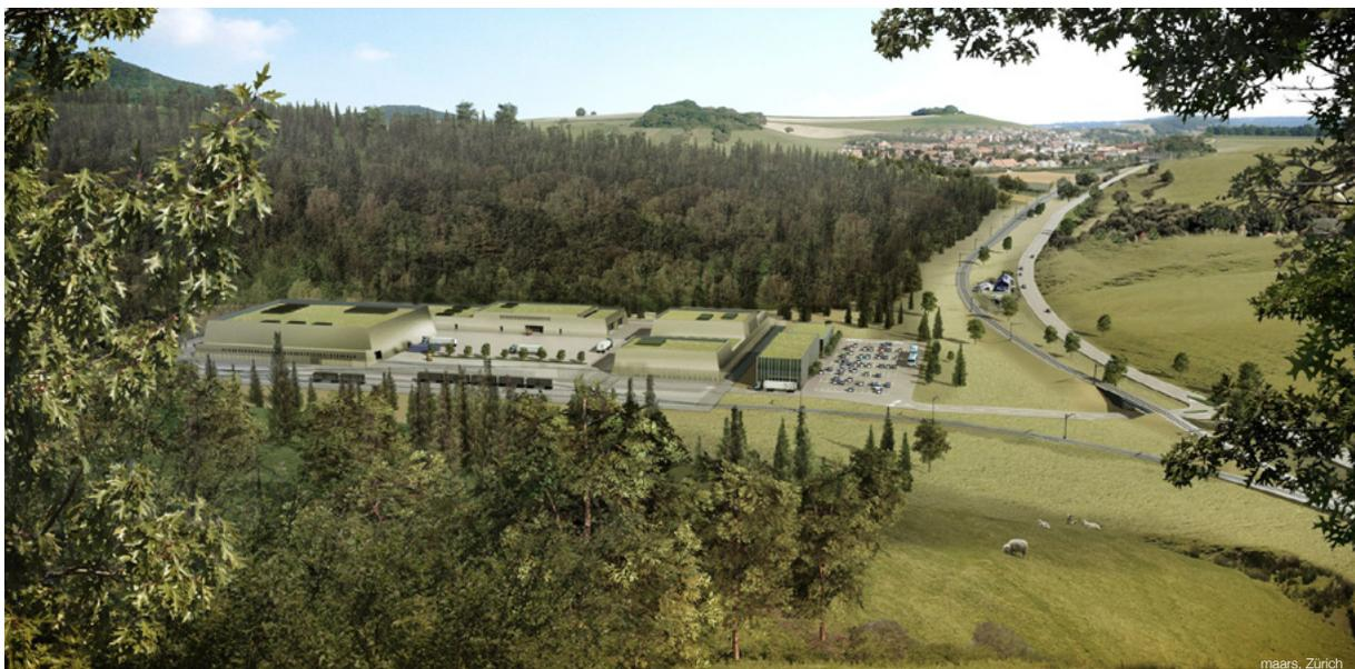
Modellhafte Darstellung der Oberflächenanlagen eines Tiefenlagers für schwach- und mittelaktive Abfälle
