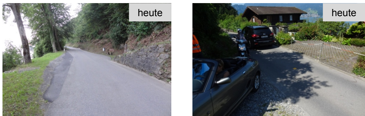
Abb. 10: Beispiel provisorischer Ausweichstellen bzw. private Zufahrten, die als Ausweichstellen genutzt werden
