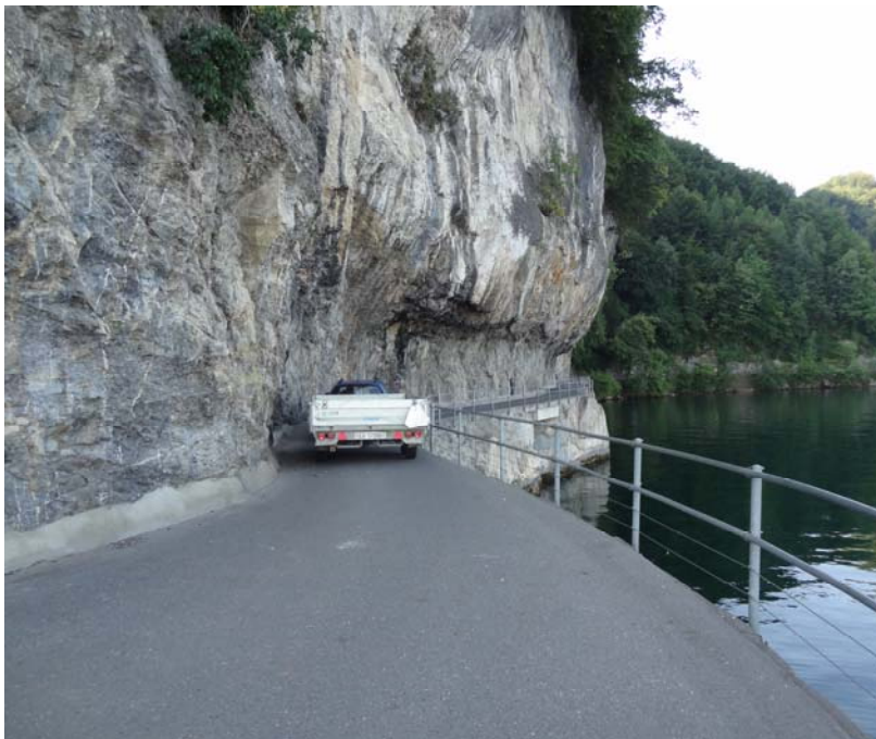
markanter Strassenverlauf der Kehrsitenstrasse
