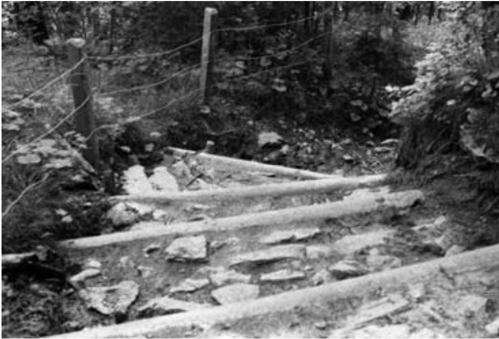
Mit grosser Anstrengung wurde der Alpweg nach Sinsgäu (NW 521) in der Rübimatt instand gestellt: Davon zeugen die Holzschwellen und steinbesetzten Trittflächen der Stufen.
