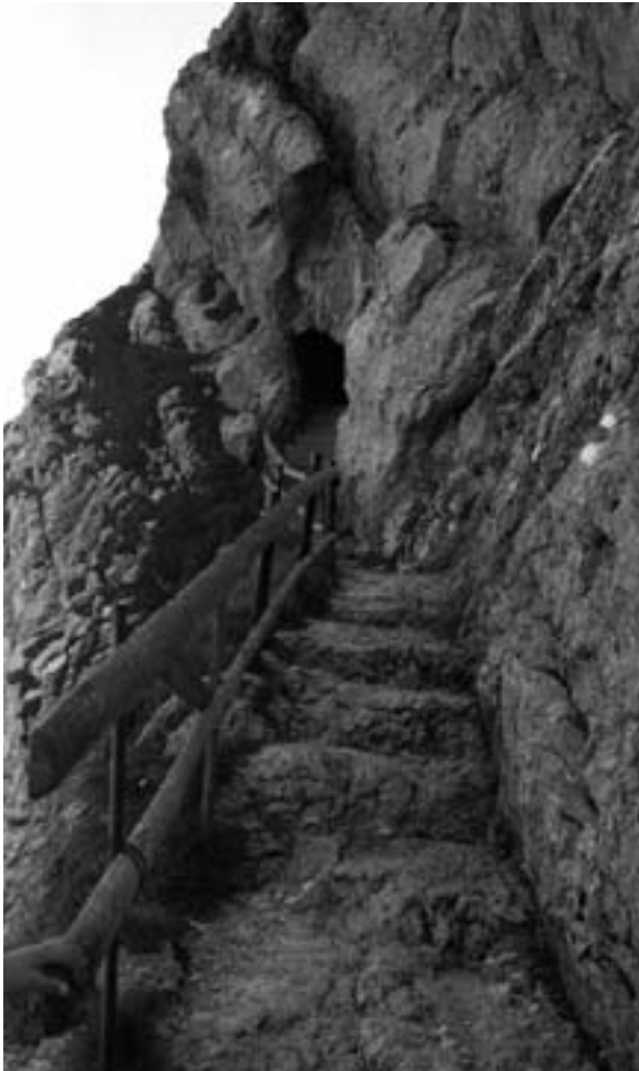
Das Chriesiloch, die oberste Felspartie des Bergweges von Hergiswil zum 1860 eröffneten Pilatus Kulm (NW 7), war ursprünglich ein natürlicher Kamin, den Steinmetzen 1855 vergrösserten. Damals wurden auch die Stein- stufen eingeschlagen.
