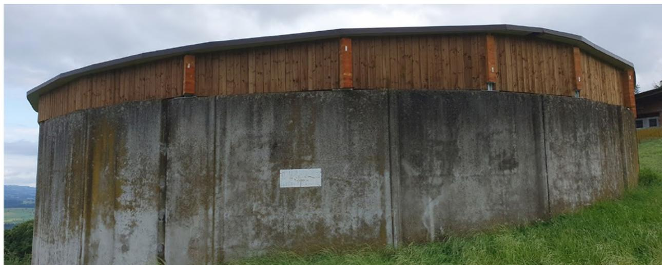
Abb. 1: Individuelle Abdeckung Holz, Stahl und Blech auf Betonsilo
